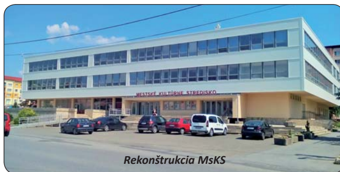
Rekonštrukcia MK - spojnica Ul. Jarková a Mudroňova
