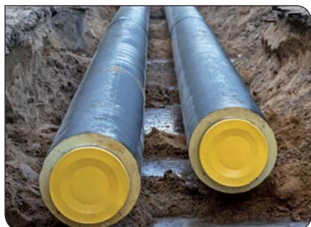
4 | Rekonštrukcia teplovodov Na jar začína rozsiahla rekonštrukcia
