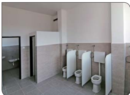
5 | Rekonštrukcia priestorov bývalého CVČ Priestory CVČ sa zmodernizovali
