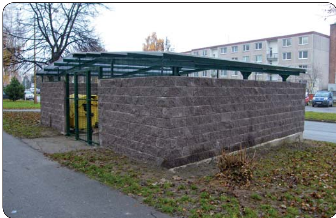
Rekonštrukcia stanovišťa kontajnerov
